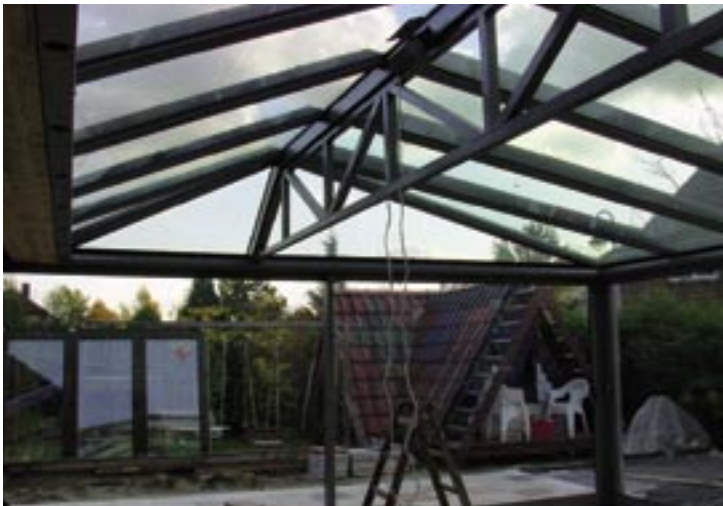
Bild 3: Die eigenwillige Veränderung des Auflagerpunktes eines Hauptsparrens sorgte in diesem Fall für unzulässigen Druck auf das Rahmenprofil
